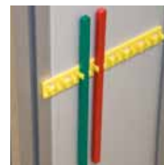
Componentele dispozitivului de blocare pentru întrerupătoare – suportul barei de blocare
